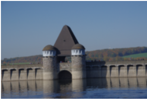
Möhne lake dam
